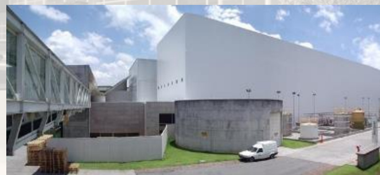
NATURA – EDIFÍCIO AV2 - ARMAZÉM VERTICAL 2 CAJAMAR SP
