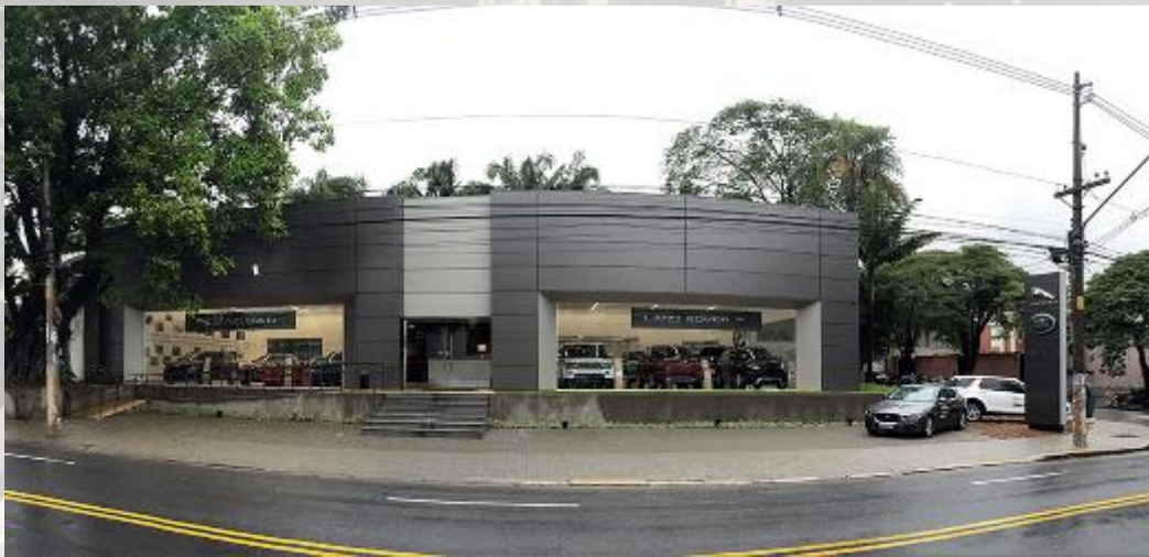
JLR RUA COLÔMBIA
