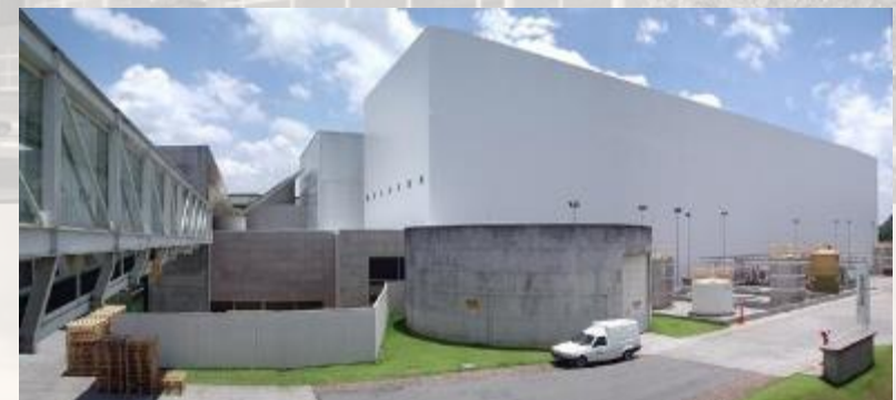
NATURA – EDIFÍCIO AV2 - ARMAZÉM VERTICAL 2 CAJAMAR SP
