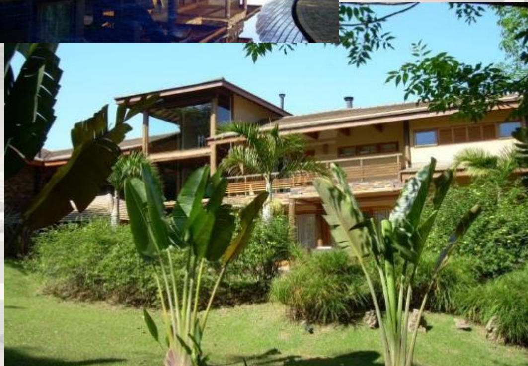
RESIDÊNCIA KIULDER - TAMBORÉ
