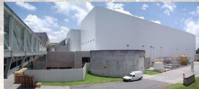
NATURA – EDIFÍCIO AV2 - ARMAZÉM VERTICAL 2 CAJAMAR SP
