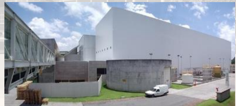
NATURA – EDIFÍCIO AV2 - ARMAZÉM VERTICAL 2 CAJAMAR SP
