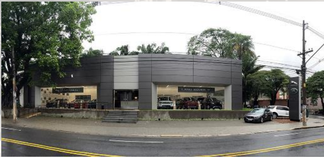
JLR RUA COLÔMBIA
