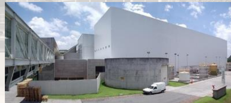
NATURA – EDIFÍCIO AV2 - ARMAZÉM VERTICAL 2 CAJAMAR SP
