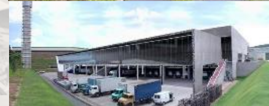
NATURA – AMPLIAÇÃO PICKING CAJAMAR SP
